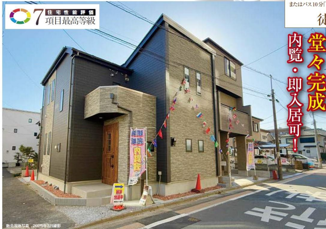
販売現地写真・2025年3月撮影
